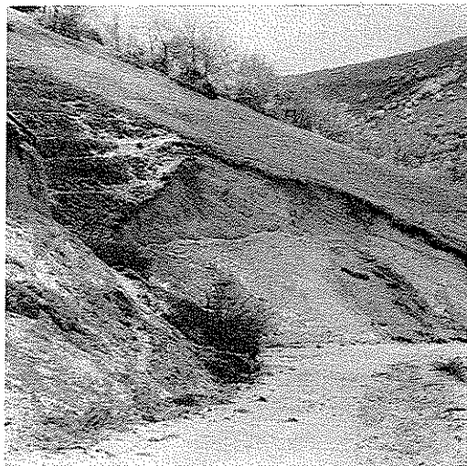
Pericolosi sbancamenti del detrito di falda fianchi del M. Acuto).
